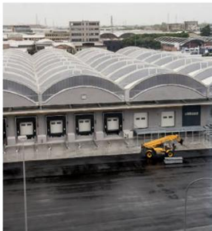
Già pronte le porte dove caricheranno i camion
