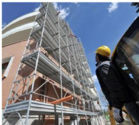
Un'immagine d'archivio di un operaio in un cantiere edile
