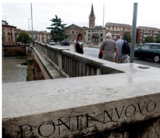
Ponte Nuovo: 3,3 milioni per ripristinare la stabilità della struttura
