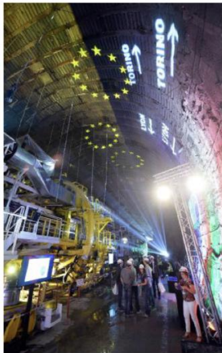
Il cantiere della Torino-Lione ANSA
