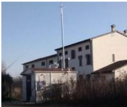
La centralina dell'Arpav al Giarol Grande
