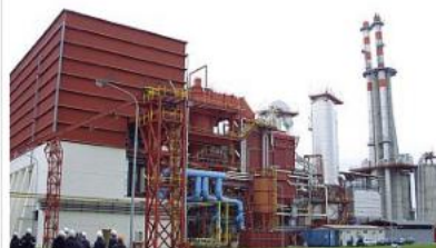
L'impianto Nato come inceneritore, Ca' del Bue oggi è attrezzato solo per il trattamento e la separazione dei rifiuti
