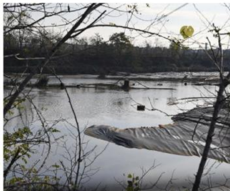
La discarica di Ca' Filissine: in corso anche l'impermeabilizzazione della superficie
