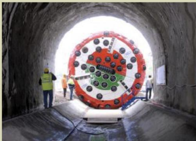
Lavori per realizzare il tunnel di base del Brennero
