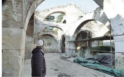
Osservazioni L'Arsenale attende i lavori di ristrutturazione
