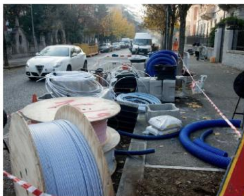
Il cantiere per la posa dei cavi di Open Fiber in via Anzani, in Borgo Trento FOTOGRAFICO
