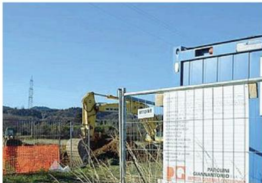
L'area Il terreno in località Testamatta a Rivoli dove dovrebbe sorgere l'impianto
