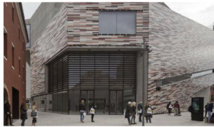
La facciata esterna di M9 a Mestre, a pochi passi da piazza Ferretto, ricoperta di piastrelle di ceramica
