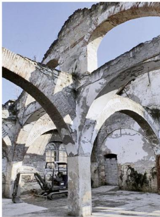
Lavori L'Arsenale a Borgo Trento attende l'intervento di riqualificazione urbanistica
