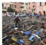
La distruzione a Boccadasse
