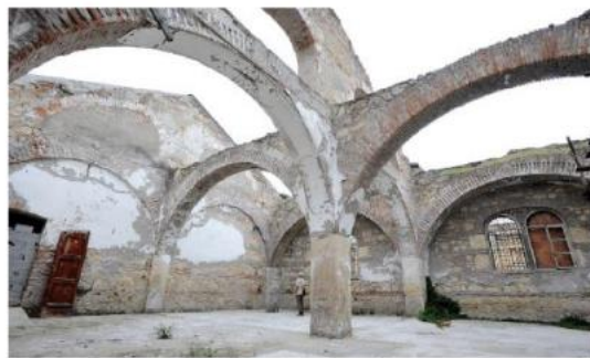
Uno degli edifici storici dell'Arsenale, che andranno ristrutturati, nel futuro complesso Ars District
