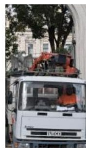
I lavori alla Nunziatura di Roma
