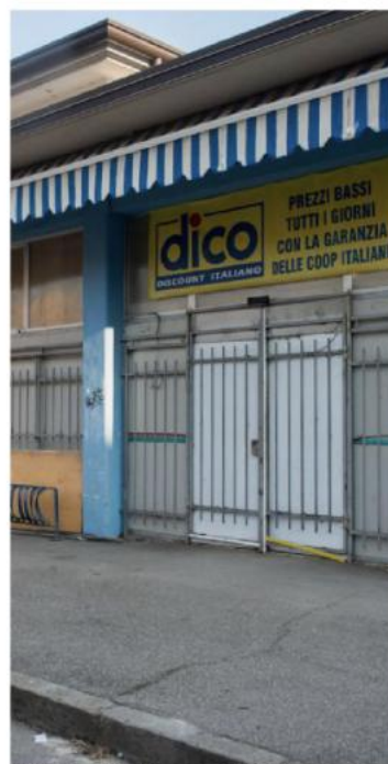
L'edificio che ospitava il supermercato degli Orti di Spagna
