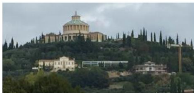
Cantiere sulle Torricelle
