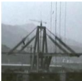
1963-'67: il ponte in costruzione
