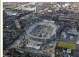
Lo stadio del Tottenham in costruzione a Londra
