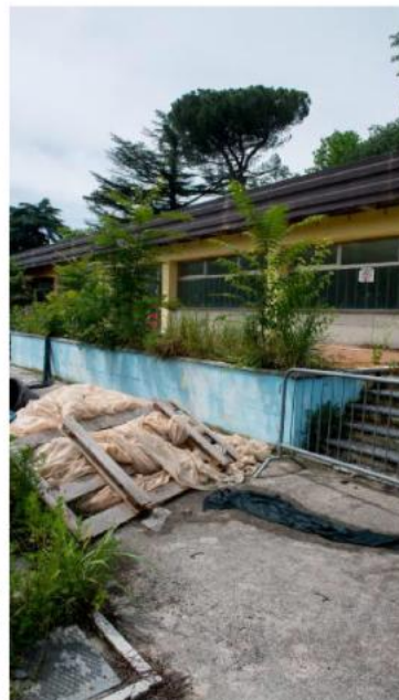
Il degrado attuale degli spazi esterni dell'impianto di viale Galliano
