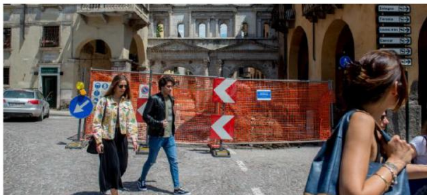
La zona recintata alla fine di corso Cavour dove è stato allestito il cantiere per evitare gli allagamenti. FOTO MARCHIORI
