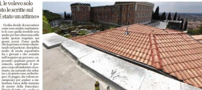
Il parapetto da cui Chiara è saltata per raggiungere il tetto della funicolare: all'atterraggio è caduta nello spazio sottostante per circa 6 metri
